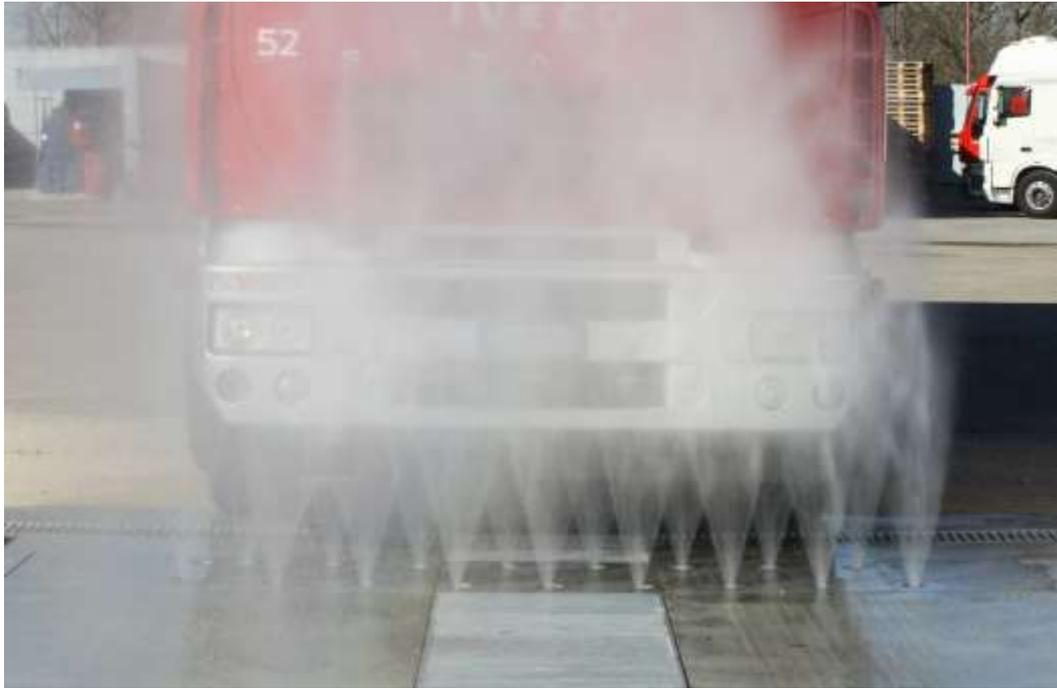
L'area di lavaggio deve essere acqua riciclata in tutte le fasi di lavaggio e solo nella fase finale di risciacquo acqua pulita per preservare il prelievo da rete idrica e scaricare in pubblica fognatura il minor volume di acqua max 300 l/m' per ogni lavaggio, riferimento autoarticolato.
